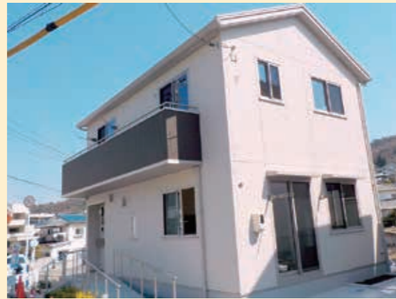
坂東三丁目住宅 2号棟
