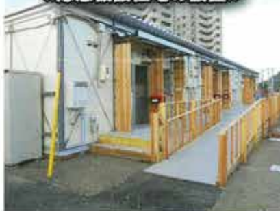
《応急仮設住宅の設置》
